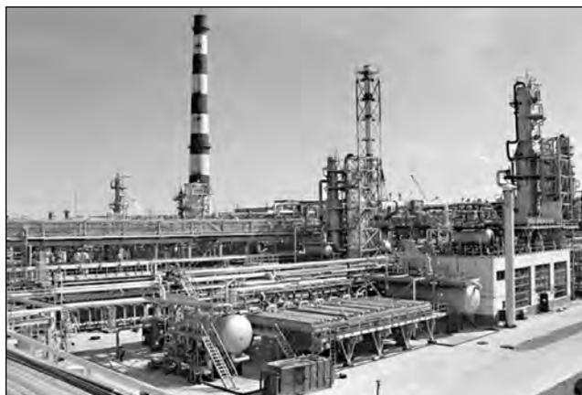
Рис. 1. Промышленная установка риформинга с периодической регенерацией катализатора
